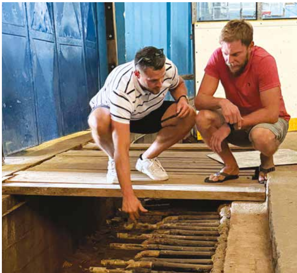
Místostarosta Jiří Motl (vpravo) a ředitel Technických služeb města Lovosice Stanislav Hruza na kontrolním dnu. Pod odkrytou částí jsou patrné rozvody chladicího systému vedoucí pod ledovou plochou. Ty ústí do rozdělovače a sběrače, jejichž nová instalace je součástí probíhající rekonstrukce chladicí technologie. Foto: Eva Břeňová
